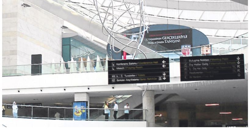
Yađmur sularının elektrik tesisatına sızmasıyla birlikte Esenbođa Havalimanı'nda sık sık elektrik kesintisi yaşandı.
