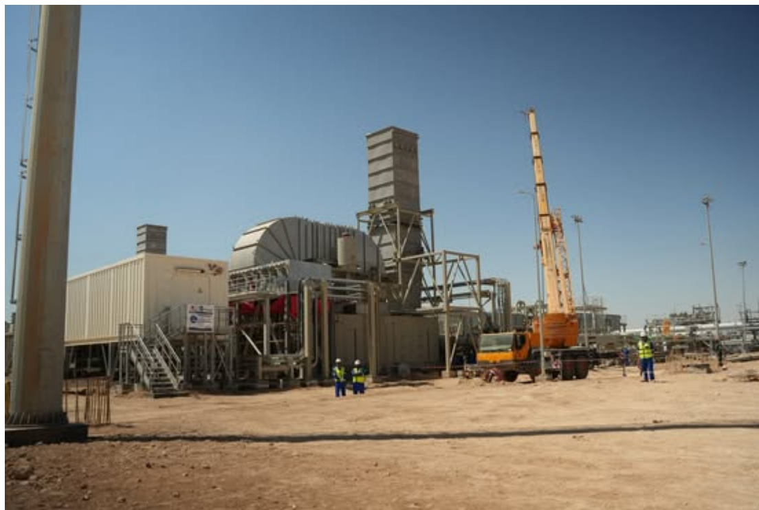
جولة ميدانية لوزير البترول لمتابعة تنفيذ مشروع استراتيجي لتطوير ودعم البنية التحتية لنقل الغاز بالأر
